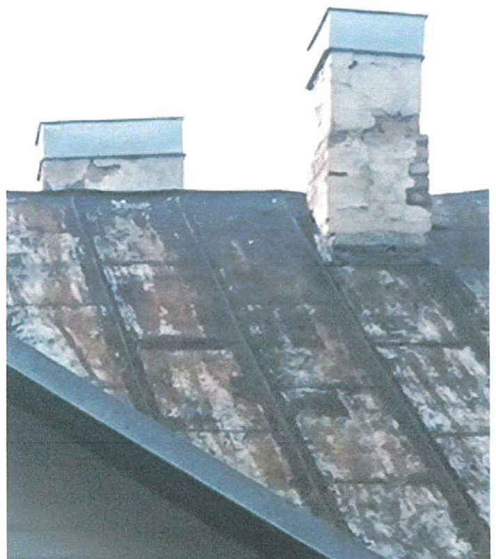
Korozijos pažeista skardinė stogo danga, pažeistas kaminų mūras ir tinkas
