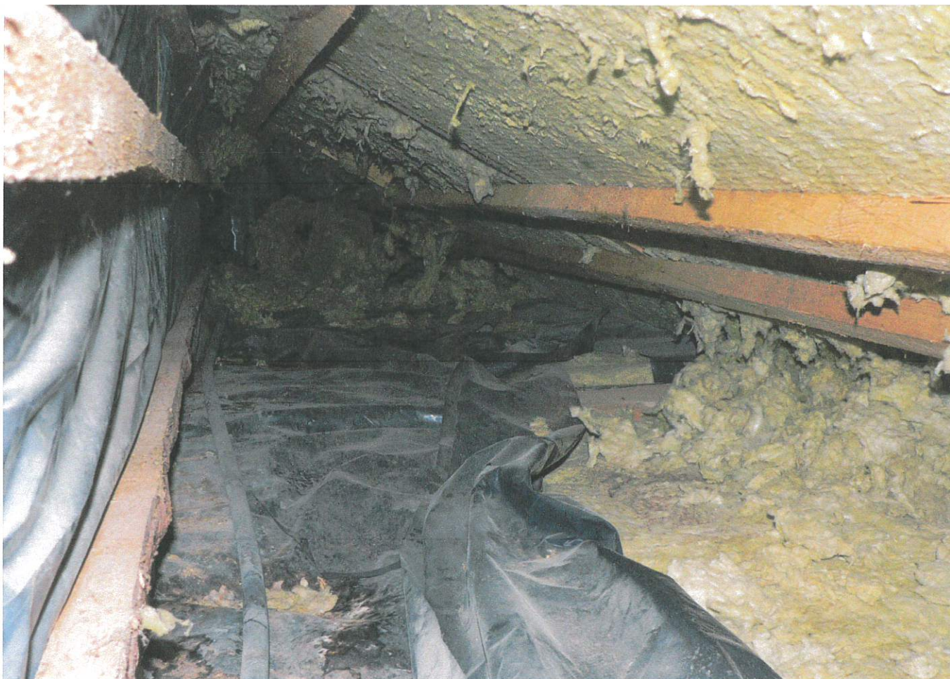
Vaizds tarp ašiu "2" - "5": stogo konstrukcija, mineralinēs vatos apšiltinimo sluksnis, PE plēvelē (XX a. pab. - XXI a. pr.)
